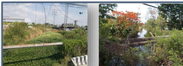
4 สภาพคลองใหม่ กม.6+321.959
