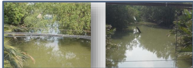
1 สภาพคลองลำโรง กม.3+767.397
